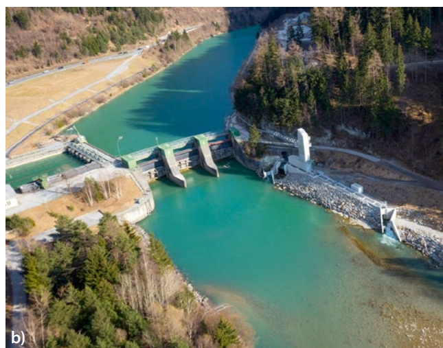
Bild 1: Kraftwerk Imst in Tirol, Österreich: a) Lage der Wehranlage Runserau, des Druckstollens und des Krafthauses bei Imst, b) Foto der Anlage Runserau vom Unterwasser (Quelle: TIWAG)
